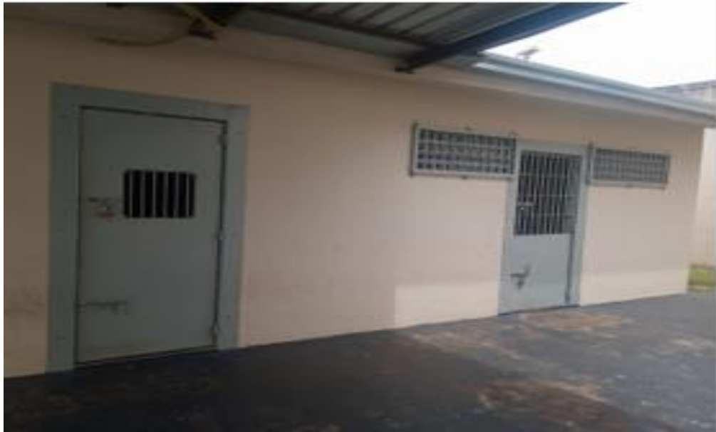
Figura 5: Sala de aula CENSE de Campo Mourão visão externa
