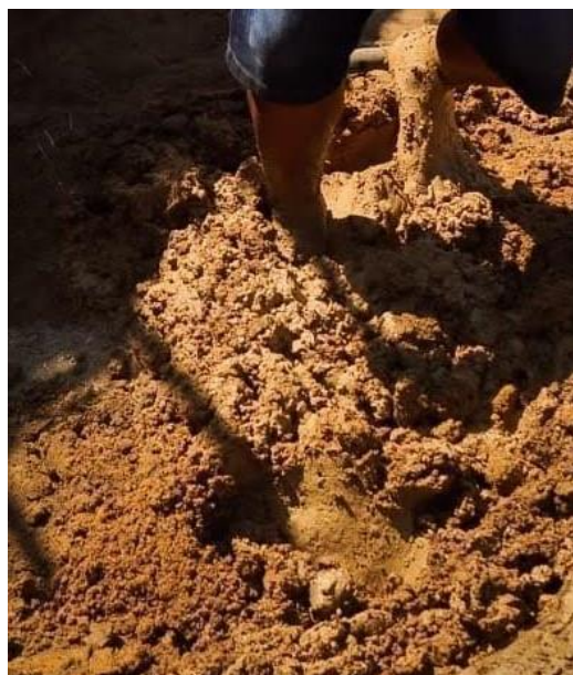
Figura 6 - Preparação da argila para embarramento Crédito: Projeto Origem
