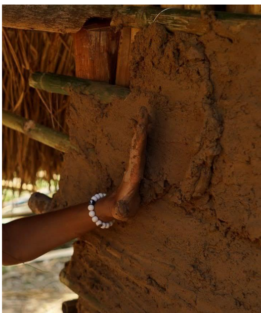
Figura 7 - Embarramento Opy Crédito: Projeto Origem
