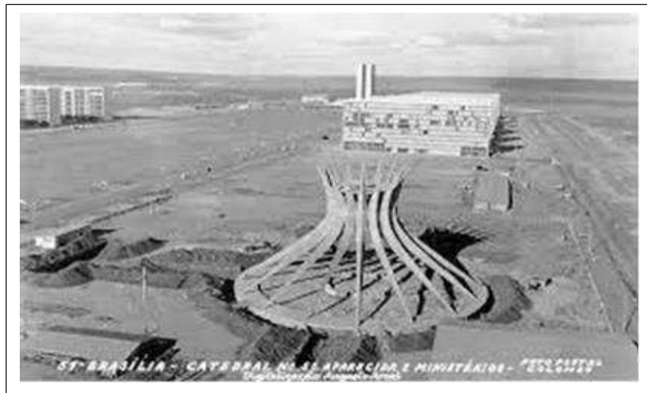
Figura 49 – Construção da cidade de Brasília
