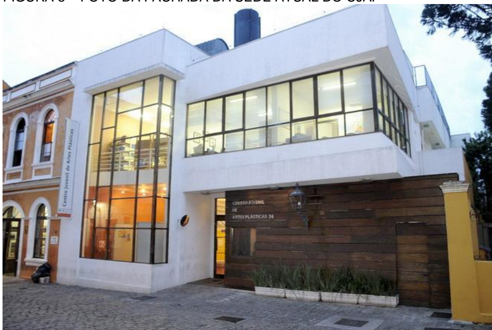
FIGURA 5 – FOTO DA FACHADA DA SEDE ATUAL DO CJAP
