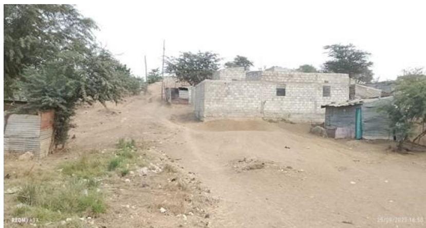
Figura 16 - estrutura habitacional do bairro Mayombe
