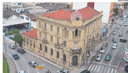
Localizado no centro de Sorocaba, na rua Souza Pereira, o Palacete Scarpa começou a ser construído em 1921.
