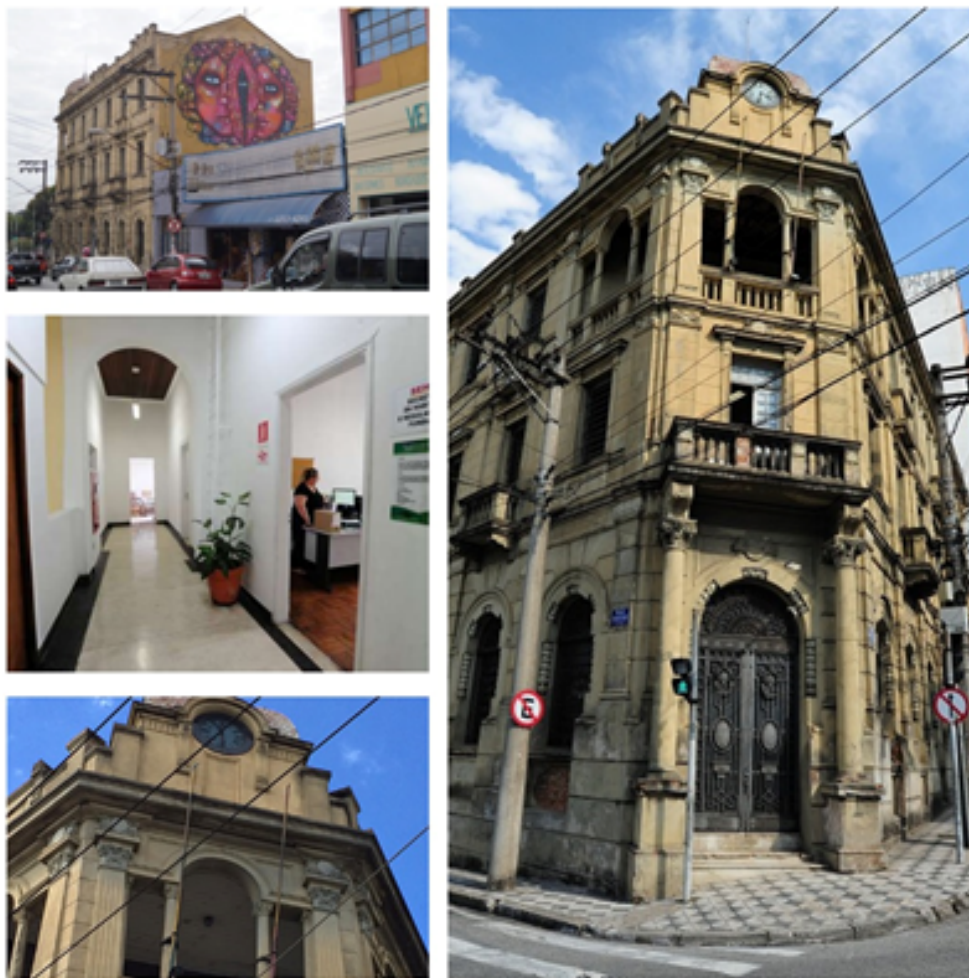
Figura 6 — Fotografia atual do Palacete Scarpa, 2018.
