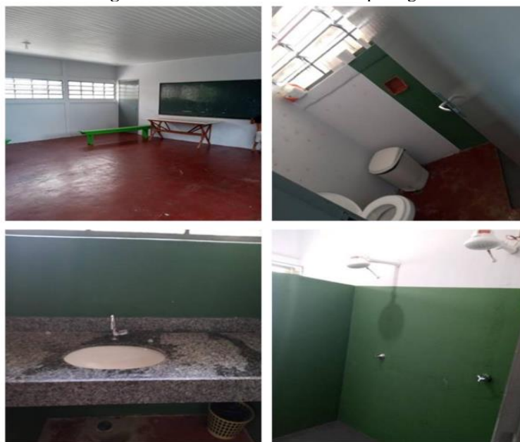
Figura 63 - Área interna da casa de passagem
