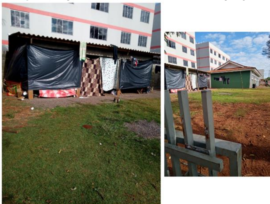
Figura 65 - Improvise com lonas na estrutura aberta da casa de passagem
