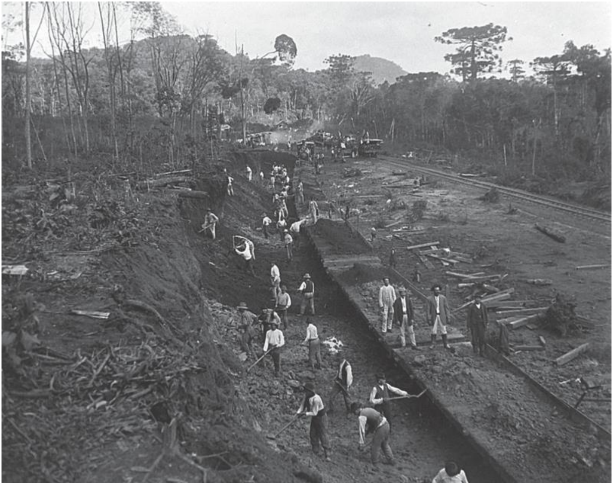
Figura 05 – Funcionários construindo a estrada de ferro São Paulo/Rio Grande do sul.
