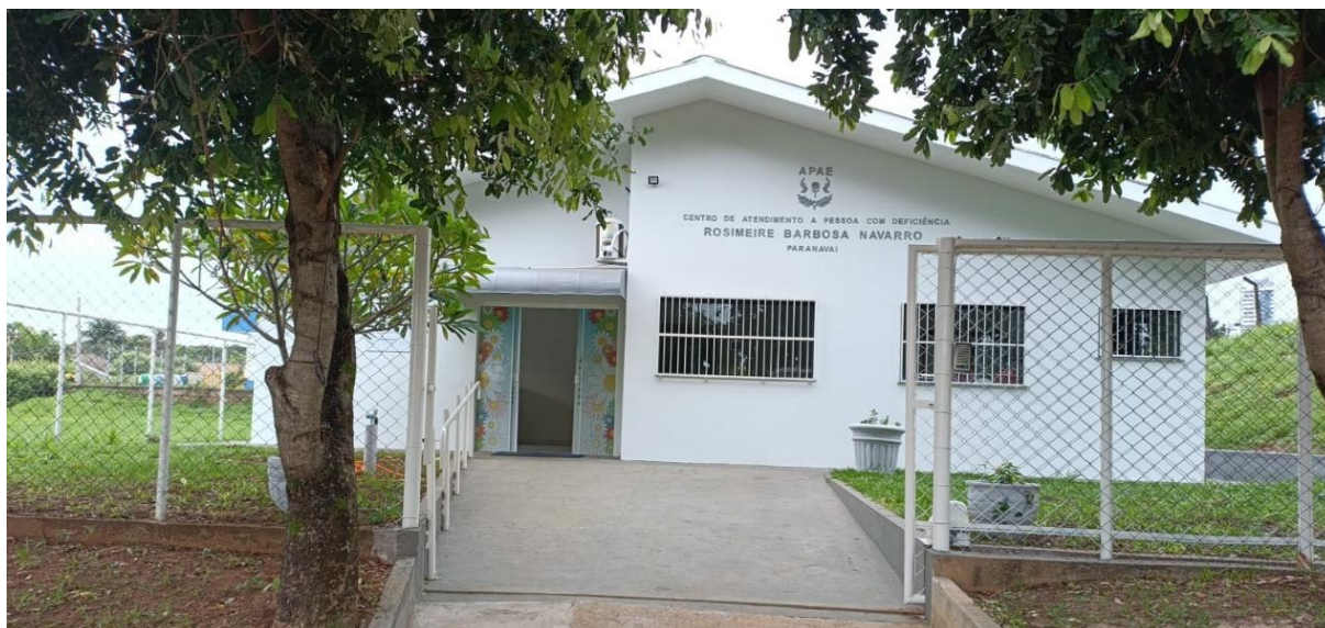
Figura 01 - Fachada do CAPD.
