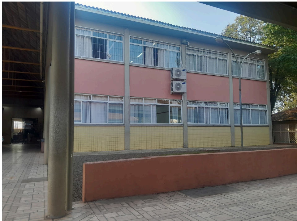
[Fig. 3: Bloco de salas de aula do Colégio Estadual Tancredo Neves]
